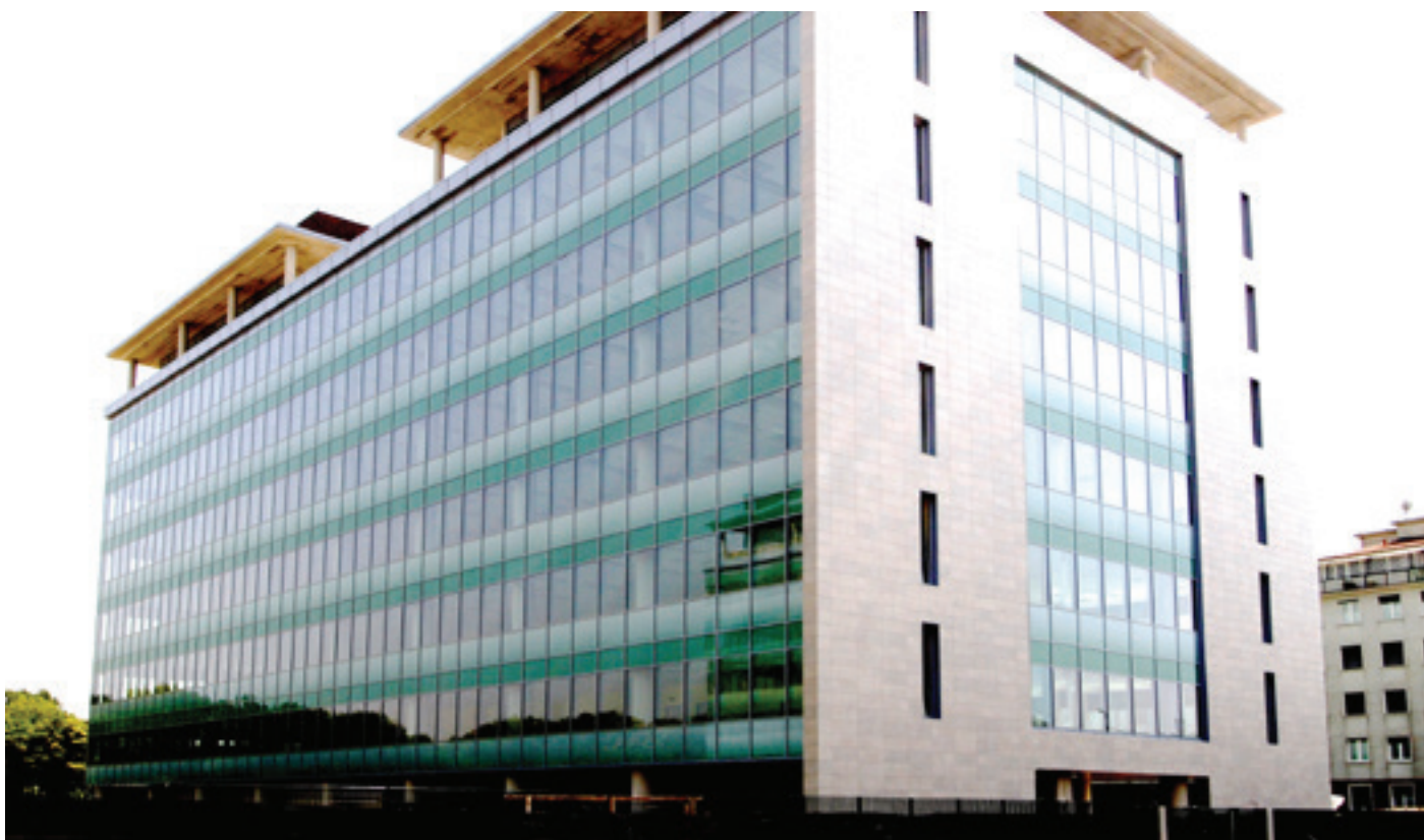
Lavoro realizzato da Luigi Cividini Spa
