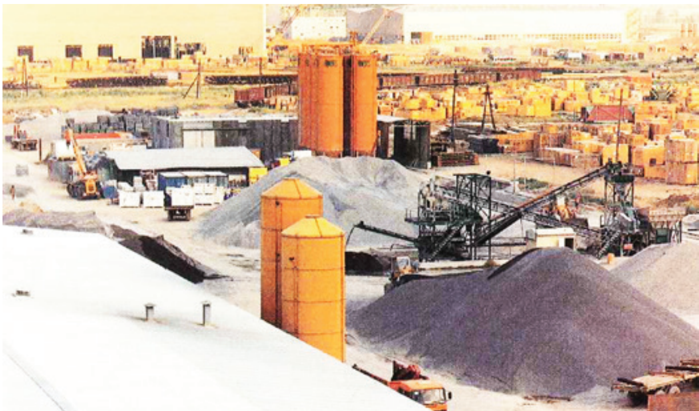
Lavoro realizzato da Luigi Cividini Spa
