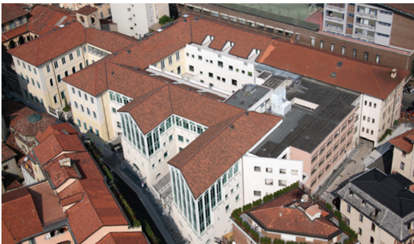
Lavoro realizzato da Luigi Cividini Spa
