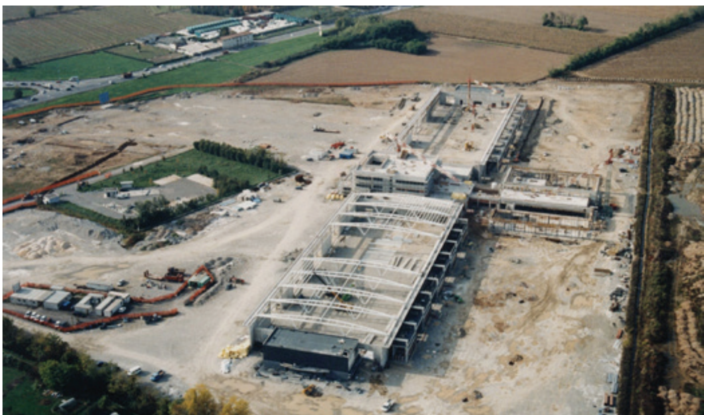
Lavoro realizzato da Luigi Cividini Spa
